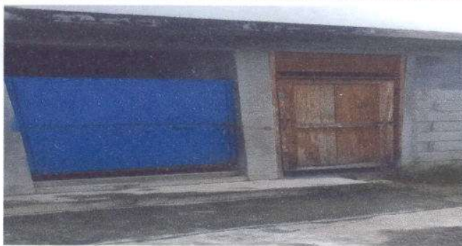
Foto 3: Mantenimiento a estructura, total 1 puerta.
