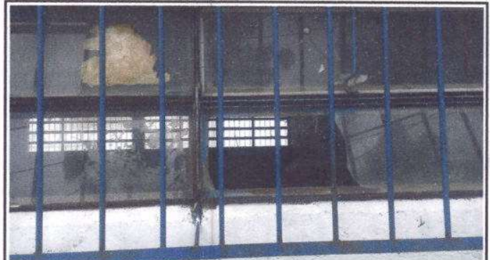
Foto 4: Sustitución de vidrios, un total de 28 unidades
