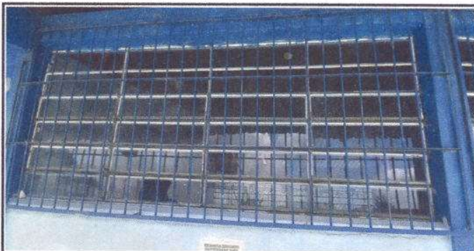
Foto 5: Sustitución de balcones de metal, un total de 15 M2.
